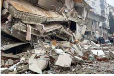
Şekil 1: 2023 Kahramanmaraş depreminde oluşan oluşan enkaz (URL-3).
