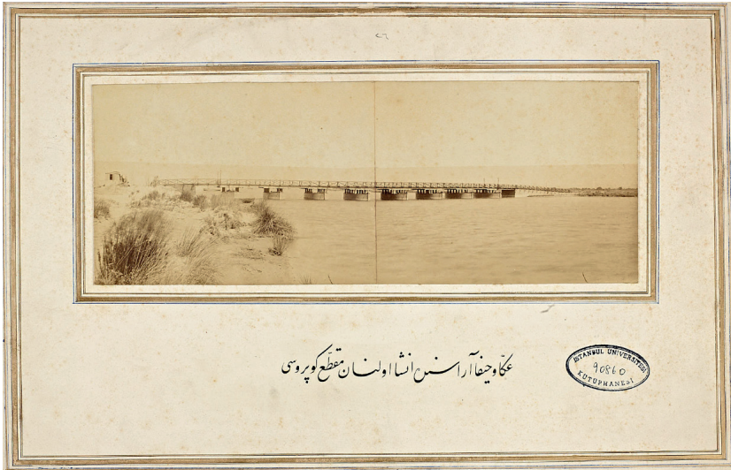
Resim 8: Akka ve Hayfa arasında inşa olunan Mukatta' köprüsü 91
