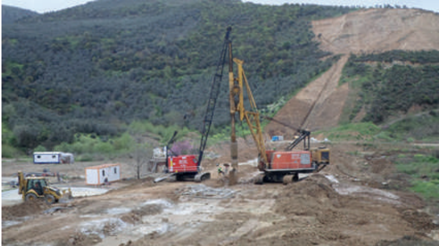
Şekil 4. Büyükkumla Barajı Slurry Trench (Geçirimsizlik Perdesi) Uygulaması
