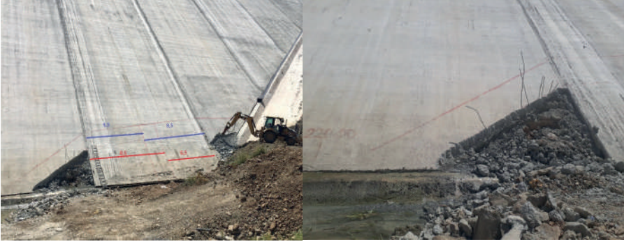
Şekil 11. Barajın Önyüzü beton Anolarında Tamirat İçin Yapılan Hazırlık.
