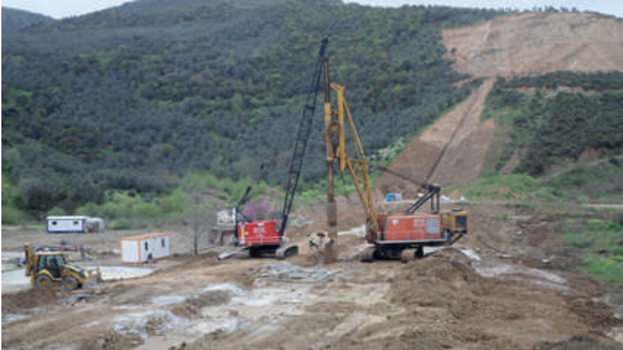
Şekil 4. Büyükkumla Barajı Slurry Trench (Geçirimsizlik Perdesi) Uygulaması
