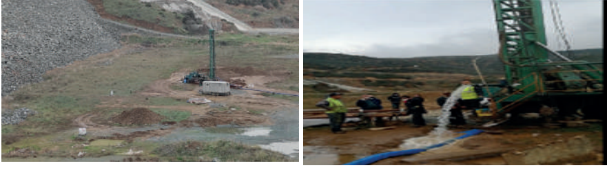
Şekil 9. Barajın Mansap Kısımında Açılan Tahliye Kuyuları
