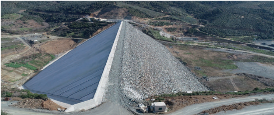
Şekil 6. Büyükkuşluk Barajı Gövdesi
