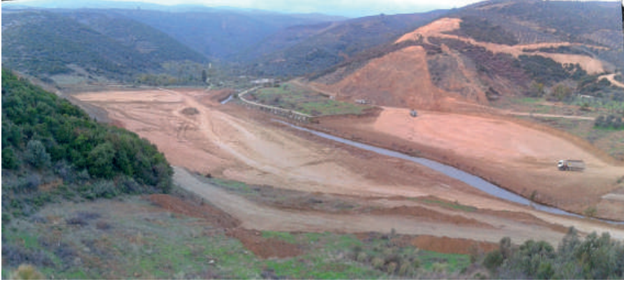
Şekil 5. Büyükkuşluk Barajı Gövde Sıyırma Kazı Alanı
