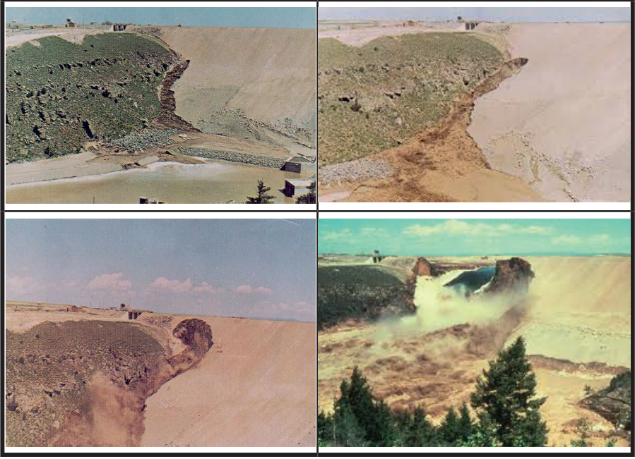
Şekil 7. Tetan barajı göçme öncesi ve göçme anı görüntüleri (Ponce vd.'den, 2020).
