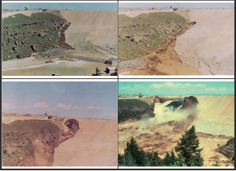
Şekil 7. Teton barajı göçme öncesi ve göçme anı görüntüleri (Ponce vd.'den, 2020).
