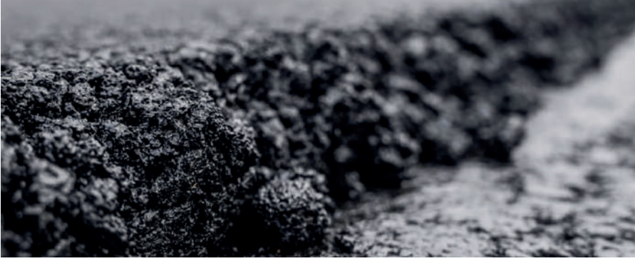
Şekil.1.1 Asfalt Kaplama Görünümü
