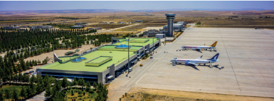
Resim 5.1. Şanlıurfa GAP Havalimanı
