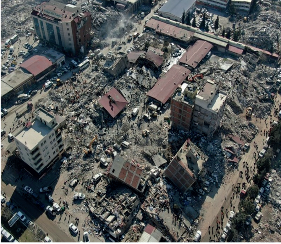
Şekil 7. 6 Şubat 2023 Kahramanmaraş Depremleri kaynaklı bina hasarları
