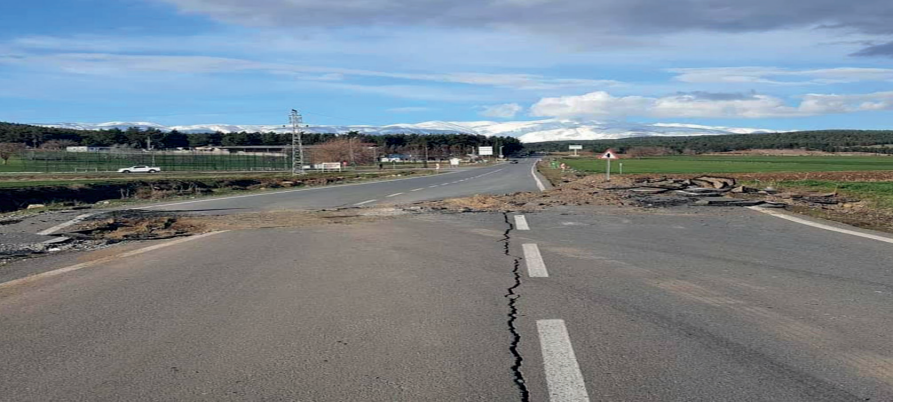
Şekil 6. 6 Şubat 2023 Kahramanmaraş Depremleri kaynaklı karayolu hasarı
