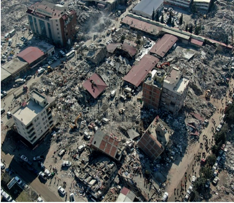
Şekil 7. 6 Şubat 2023 Kahramanmaraş Depremleri kaynaklı bina hasarları
