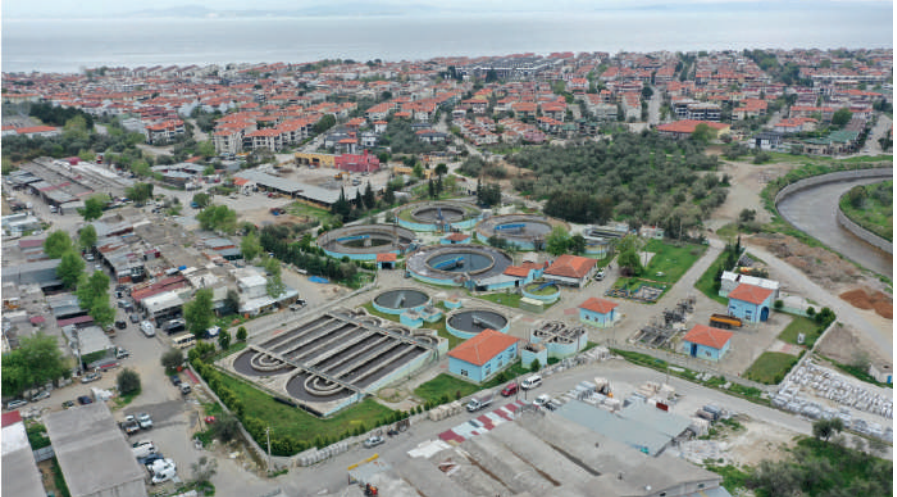
Şekil 6: Gri Su Geri Kazanım Tesisi (Kaynak: Balıkesir Büyükşehir Belediyesi,2023)
