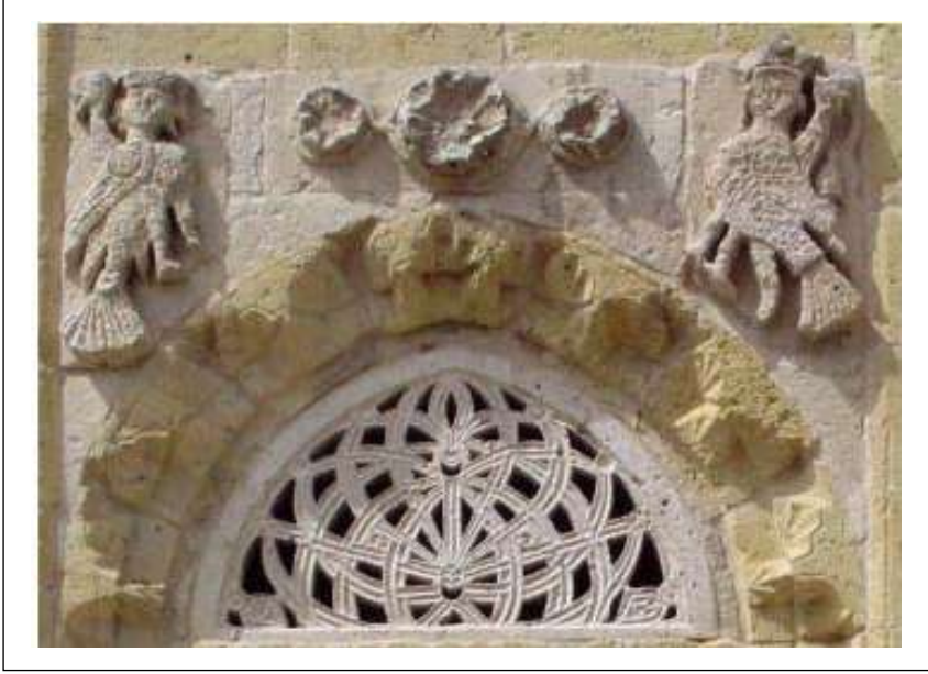
Şekil 65: Niğde Hidavet Hatun Türbesi'nde Siren Kabartması
