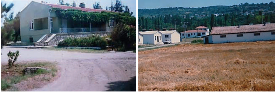
Şekil 3.14: 'T.C. Çanakkale Meyvecilik İstasyonu Müdürlüğü' 'Bayramiç' (a) ve 'Umurbey' (b) İşletmeleri (Orijinal)
