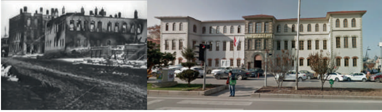
Fotoğraf 20. Erzurum Adliyesi Yangın Sonrası Görünüm Fotoğraf 21. Erzurum Adliyesi
