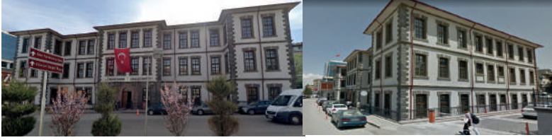
Fotoğraf 11. Erzurum Hükümet Konağı Cephe Görünümleri
