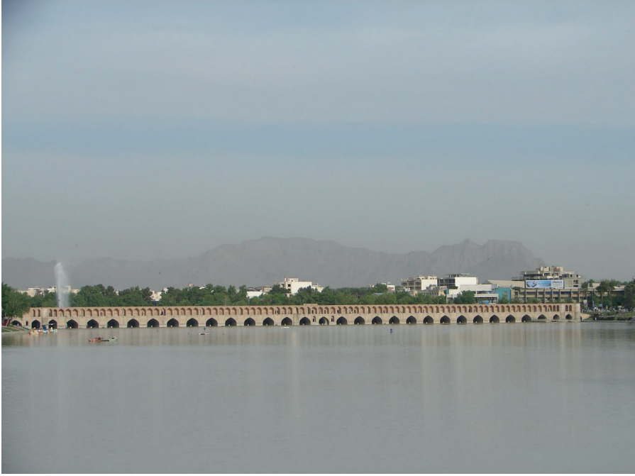
Şekil 4, Zâyenderûd Nehri ve Safevîler zamanında inşa edilen Siyose (Otuş Üç) Köprüsü (Url-4)
