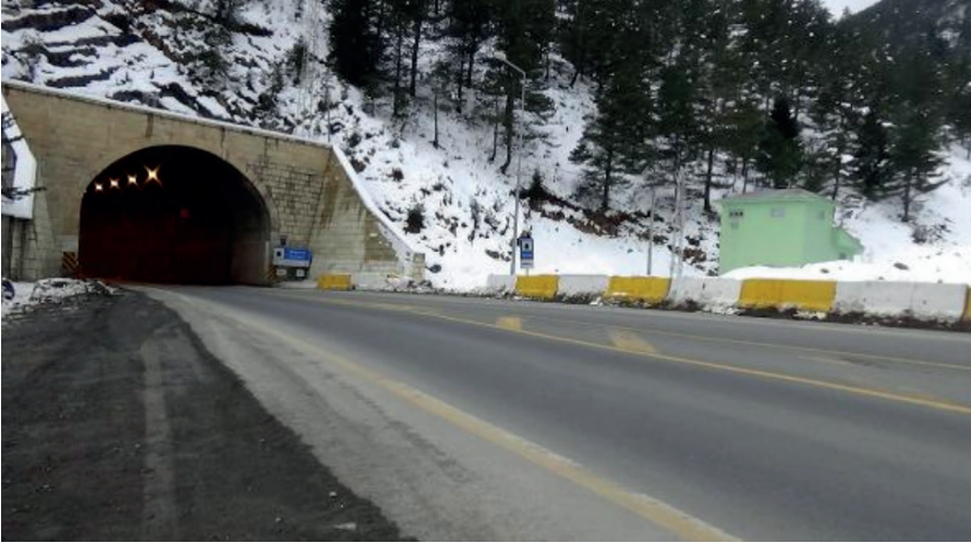
Foto 1: Eski Zigana Tüneli
