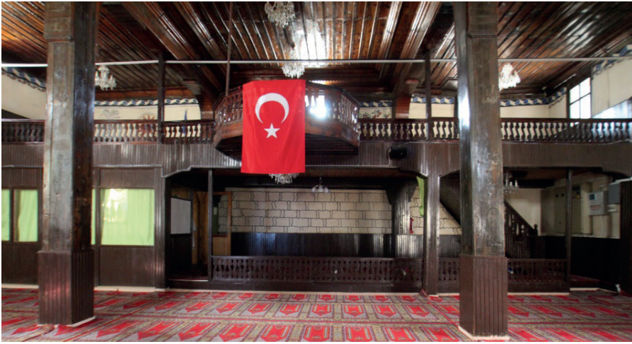
Resim 18; Doğanhisar Deştiğin Ulu Camii, kuzey duvarı
