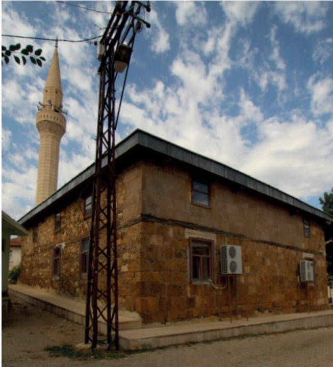
Resim 2; Doğanhisar Deştiğin Ulu Camii, güney batı cephesi
