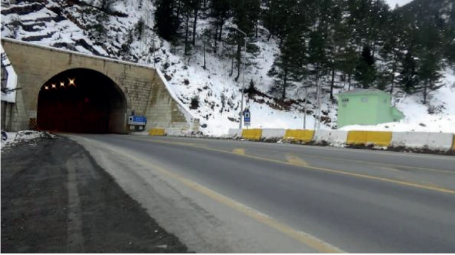
Foto 1: Eski Zigana Tüneli
