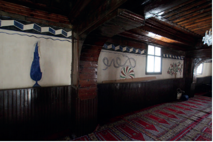
Resim 20; Doğanhisar Deştijîn Ulu Camii, kadımlar mahfeli, kuzey duvarı
