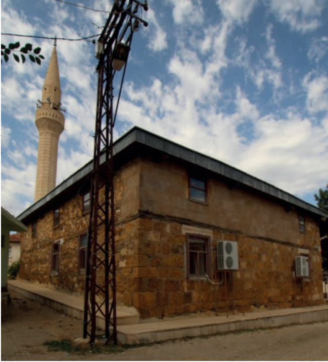
Resim 2; Doğanhisar Deştiğin Ulu Camii, güney batı cephesi
