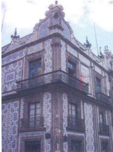
Görsel 12. Mexico. Dış cephesi seramik kaplı yapı (Çobanlı ve Okur, 2006).
